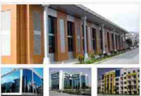
طراحی و اجرای انواع نمای ساختمان : گسترشیت، اسپاندر و کرتین وال
