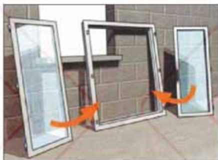
شکل ۲۱ لزوم علامت گذاری قطعات چارچوب و لنگه باز شوها در صورت انبار کردن جداگانه
