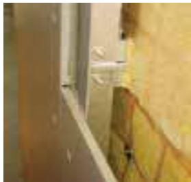
اتصال با استفاده از پروفیل‌های فلزی سراسر و با ایجاد پل‌های حرارتی متعدد
