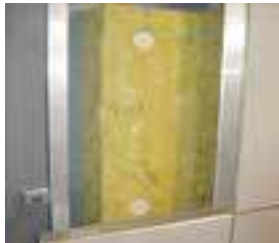
نمایی از نحوه اجرای عایق حرارتی در پشت صفحه سیمانی با استفاده از اتصالات فلزی منقطع
