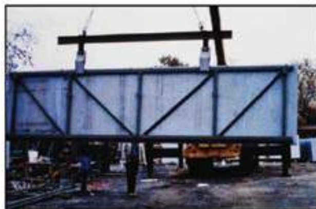
شکل ۴- پانل دیواری پرده ای پیش ساخته سنگی
