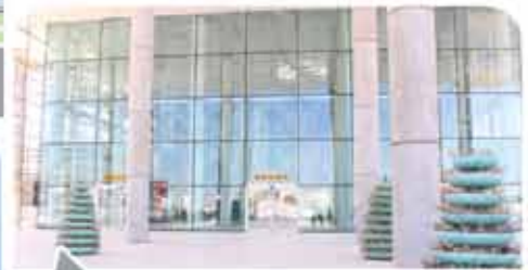
تهران - ایستگاه مترو شهر آفتاب
