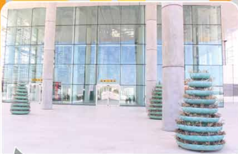
تهران - ایستگاه مترو شهر آفتاب
