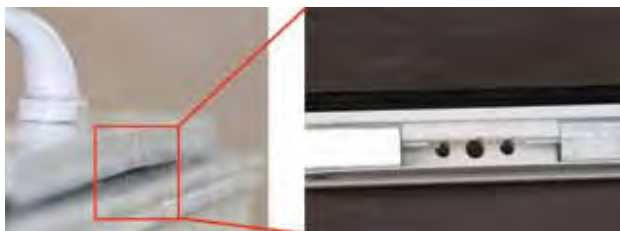
شکل ۴- تصویر تحدب و تقعر پنجره از ناحیه پروفیل
