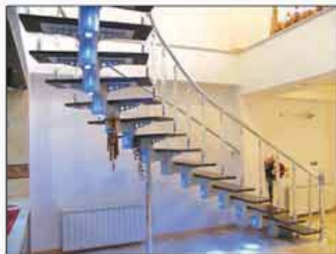
پله های حلقه ای با سازه فولادی و کف MDF
