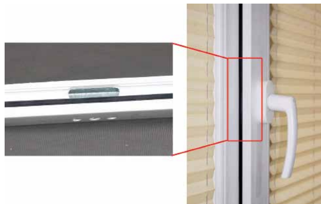
شکل ۱- یک تکه بودن گالوانیزه در ضلع دستگیره
