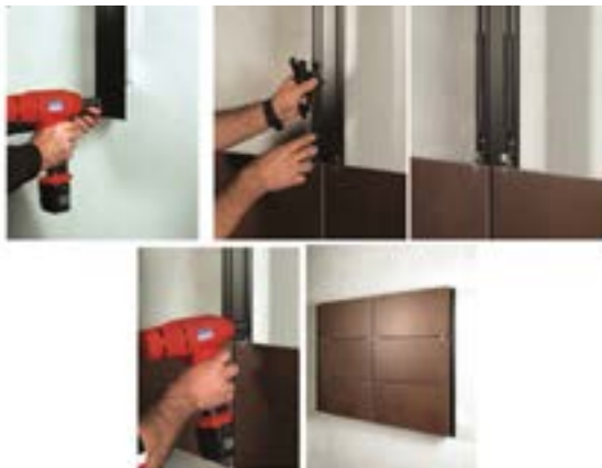
مراحل نصب سیستم نصب نمایان
