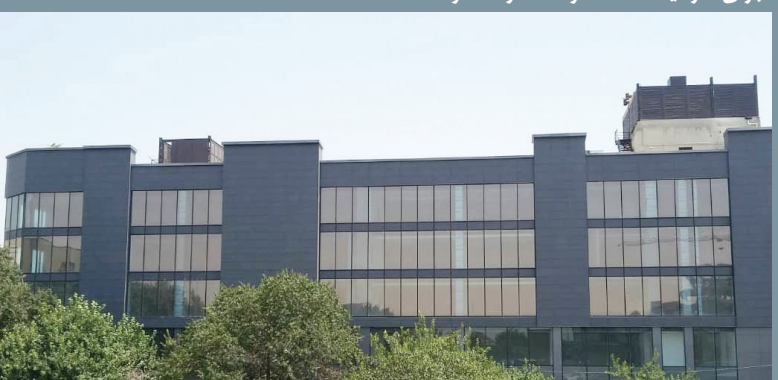
اجرای سرامیک خشک توسط شرکت آلوکد
