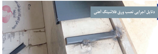
دتایل اجرایی نصب ورق فلاشینگ آهنی
